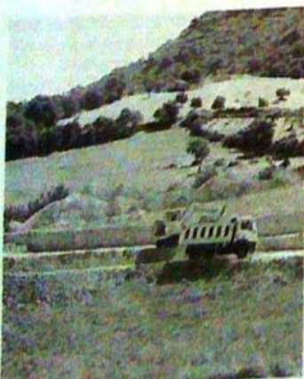
IL CANTIERE DI CONTRADA TIMPONAZZO
